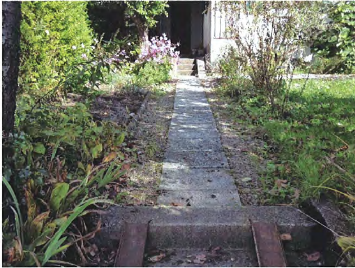
Abb. 5 Imbisbühl 18. Vorgarten im ursprünglichen Zustand erhalten.
