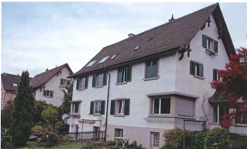
Nrn. 27 und 29, Südfassaden mit Eckfenstern
