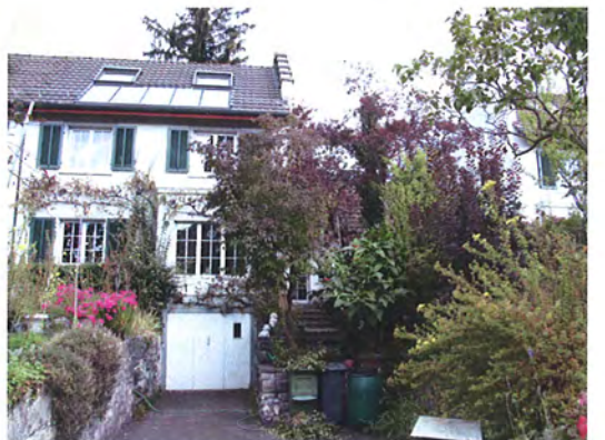
Nr. 36, Garage im Kellergeschoss, Dachfläche mit Sonnenkollektoren
