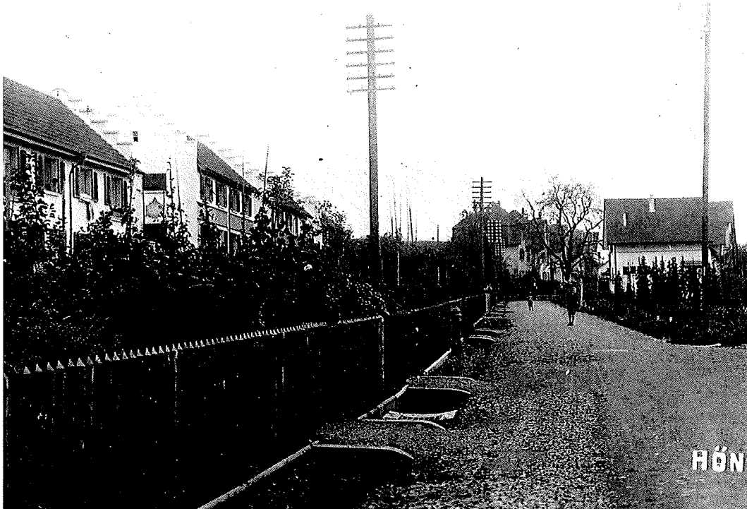
Abb. 2 Vor 1925 Postkarte Bauetappe I & II. Die Vorgärten der ersten beiden Bauetappen, noch mit Holzlatenzäunen (erstellt von der Fa. Müller-Bührer, Lönigen) und ursprünglicher Strassenentwässerung. Die Strasse war geschottert. Rechts der kommende Bauplatz der IV. Bauetappe (1925). Q: Privat.
