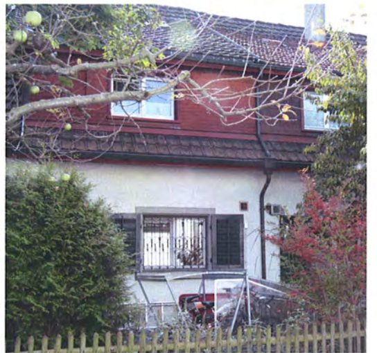
Nr. 16, Nordfassade mit Schlepptgaube
