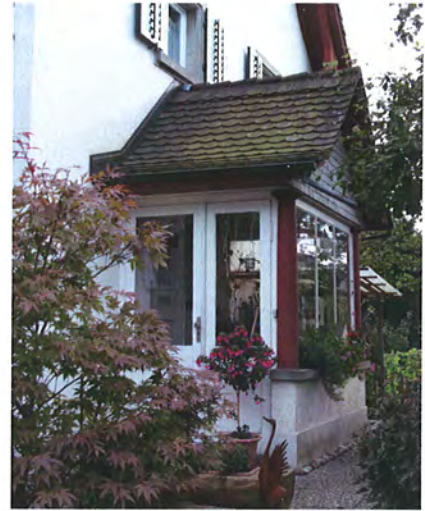
Nr. 25b, Eingangsvorbau
