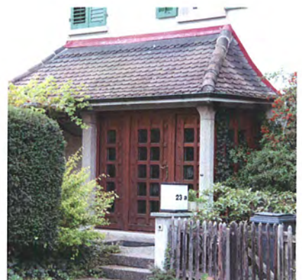
Nr. 23a, Eingangsüberdachung, baulich geschlossen
