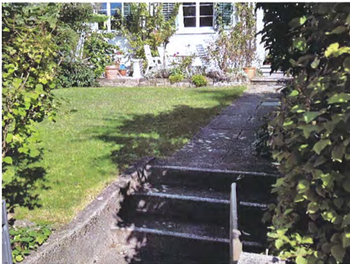
Abb. 6 Imbisbühl 20. Grundstruktur der Bauzeit 1922 erhalten.
