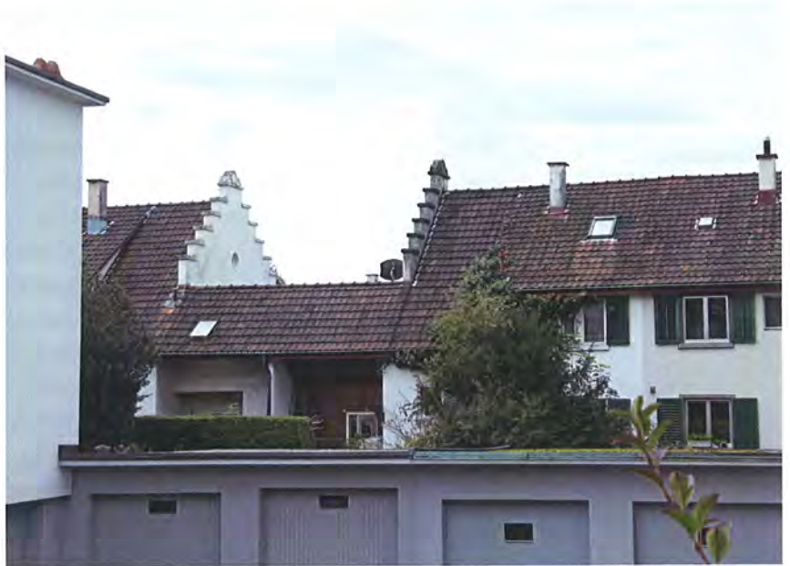
Imbisbühlstr. 46 und 48, rückseitige Dachflächen
