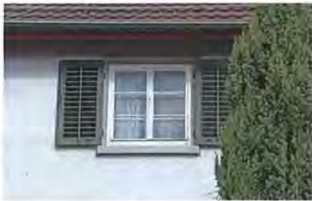
Imbisbühlstr. 42, Fenster mit ursprünglicher Fenstersprossung
