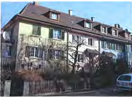
Reiheneinfamilienhäuser der Siedlung Möhrlistrasse (Baugenossenschaft Vrenelisgärtli)
